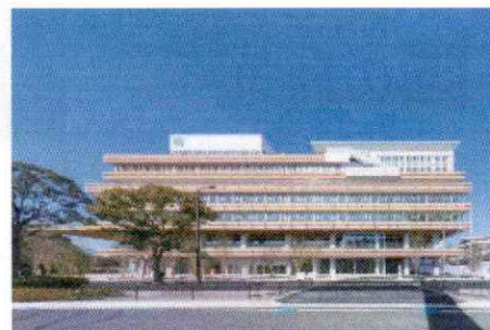
写真:千葉市新庁舎(ZEB Ready)(出典 千葉市)
